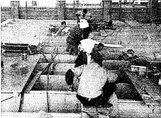
電解槽塩ビライニング工事
